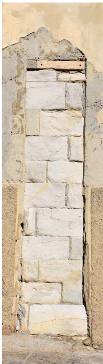
Brevi filaretti in elevato di pietra calcarea alberese bianca, unici resti murari della chiesa di S. Lorenzo.
