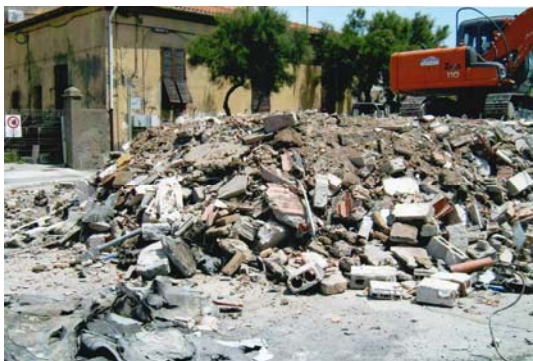
Il "barrino" costruito nel 1948 e demolito nel giugno 2008
