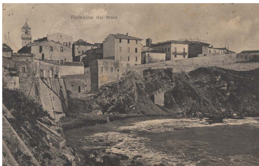
Le case da demolire e sulla spiaggia l'intera canale che portava i liquami in mare.
