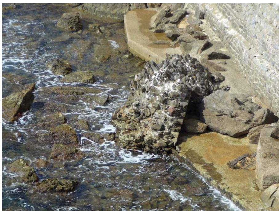
Frammenti murari della distrutta Rocchetta
