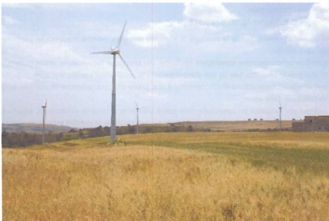
Fig. 1.4 - Esempio d'installazione Aerogeneratori Tozzi Nord TN535
