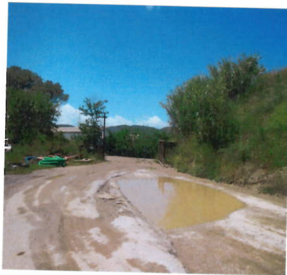
Foto n. 1 – Vista dall'interno dell'ingresso al sito. (sulla dx è visibile l'argine in terra alto 5 metri e un cumulo di materia prima secondo con folta vegetazione)
