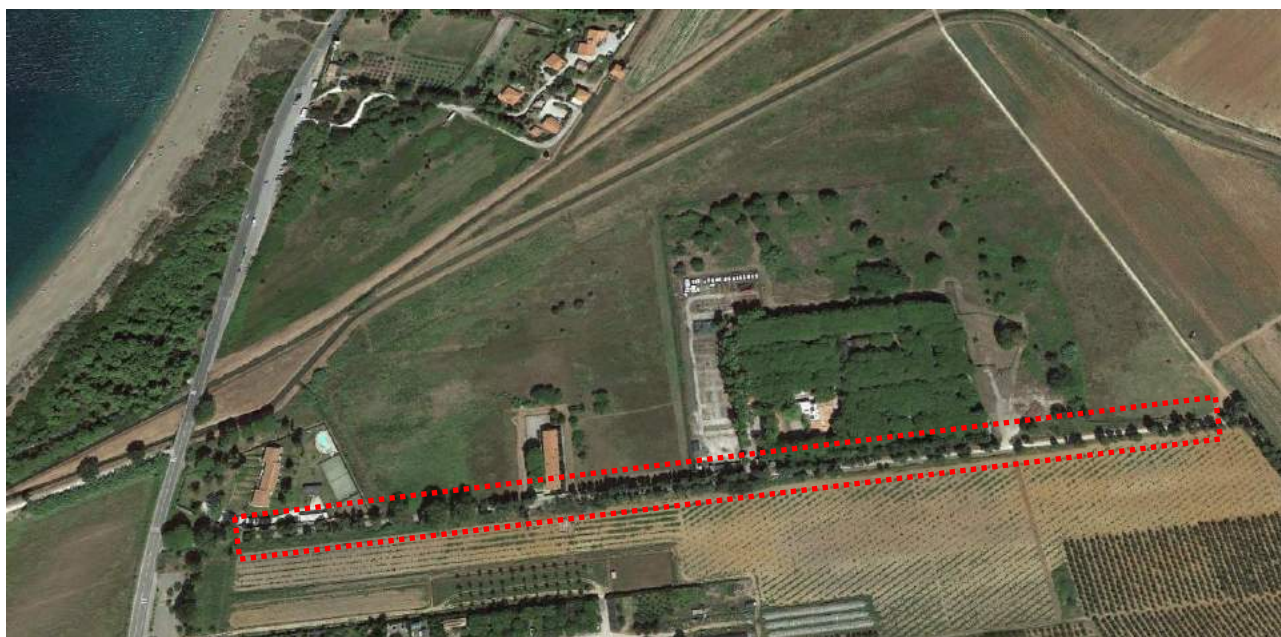
Figura 4-6: Inquadramento strada comunale oggetto di adeguamento – base googleEarth.
