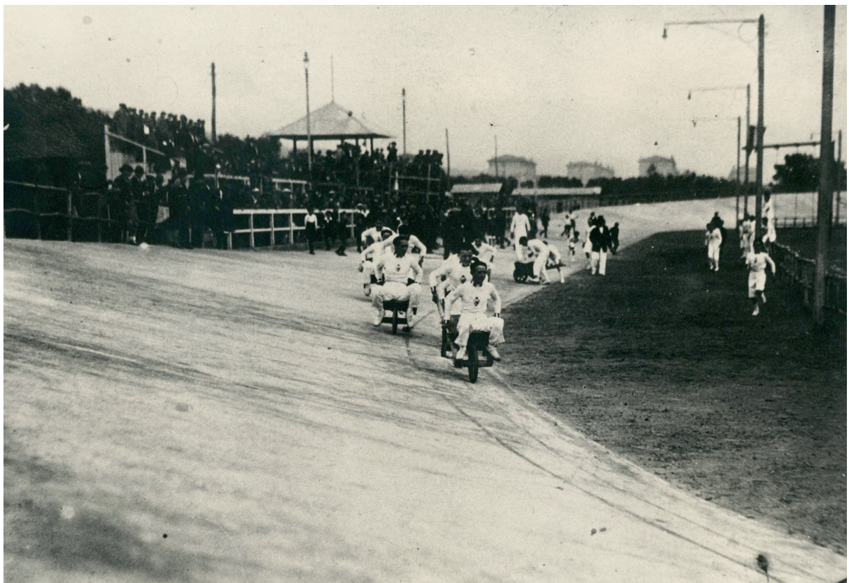
Corsa con carriole (foto n. 23276)
